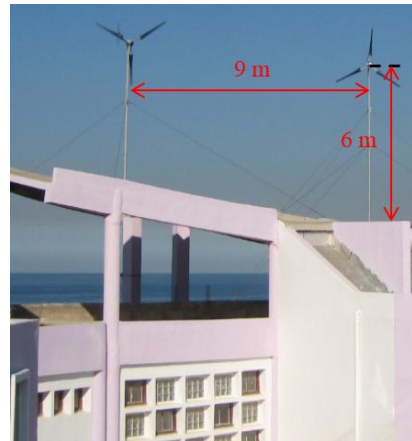
Fig. 12. Installation des éoliennes
